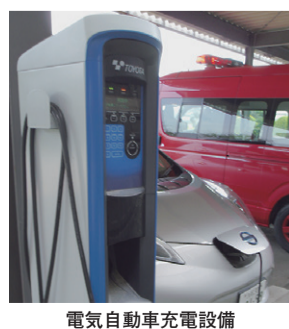
電気自動車充電設備
