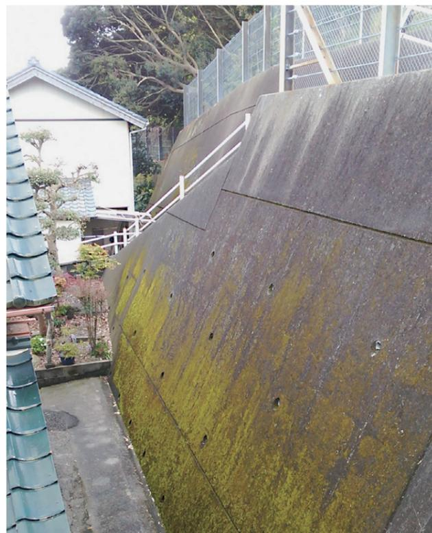
急傾斜地崩壊対策擁壁
