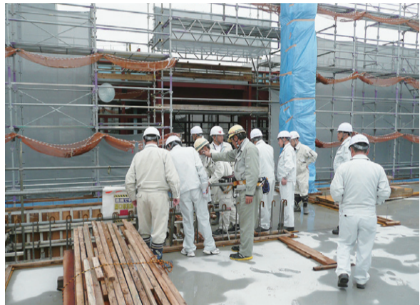
新消防庁舎建設
