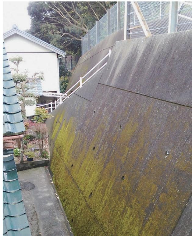
急傾斜地崩壊対策擁壁
