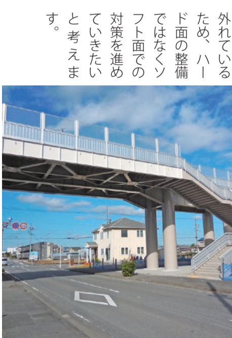
吉田町の歩道橋兼津波避難タワー
