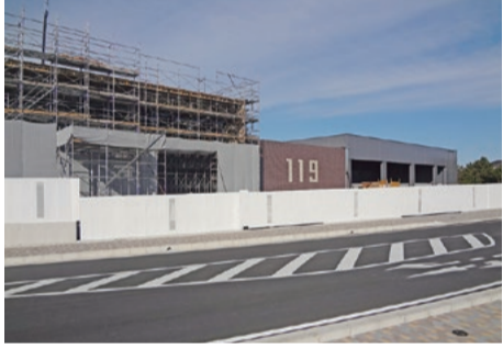
建設中の新消防庁舎
