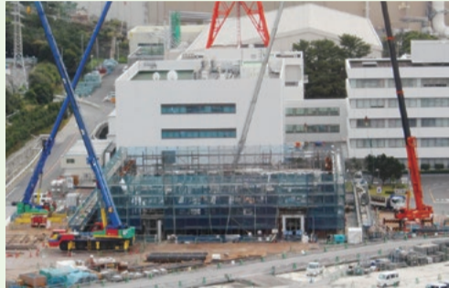
緊急時対策所建設工事
