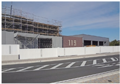
建設中の新消防庁舎
