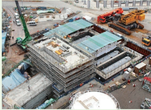
4号機軽油タンク地下化工事
