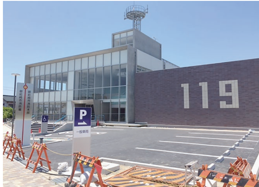
完成間近の消防庁舎
