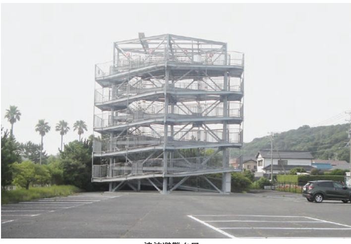
津波避難タワー
