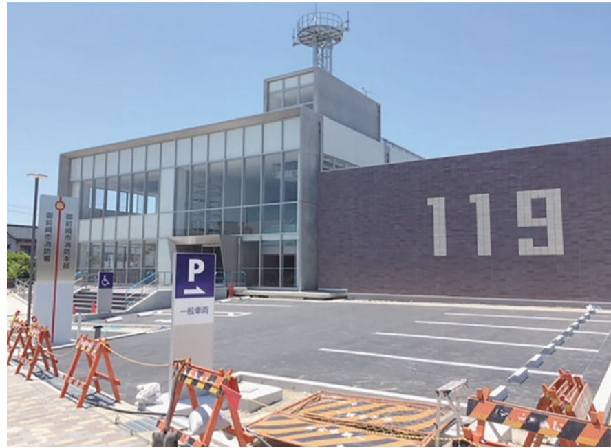
完成間近の消防庁舎
