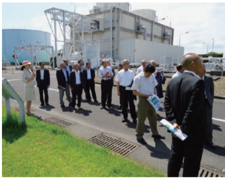
山川地熱発電所
