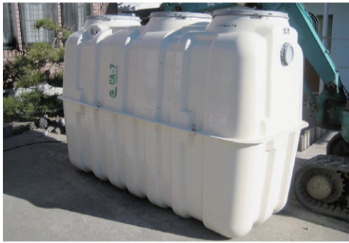
合併処理浄化槽
