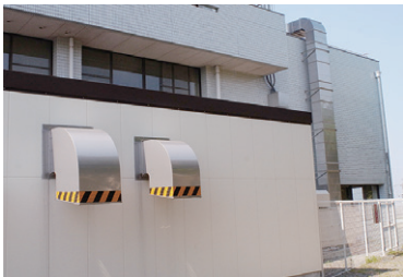
放射線防護対策工事（市立御前崎総合病院）
