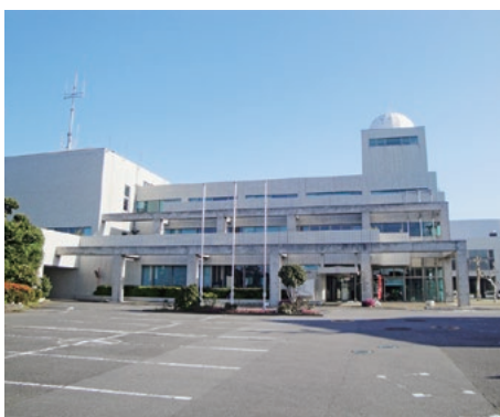
御前崎市消防署の(仮称)白羽出張所
