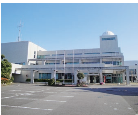
御前崎市消防署の(仮称)白羽出張所
