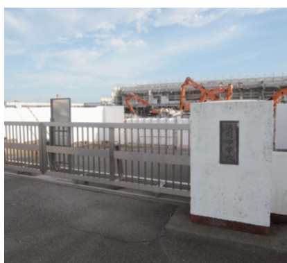
解体中の浜岡中学校
