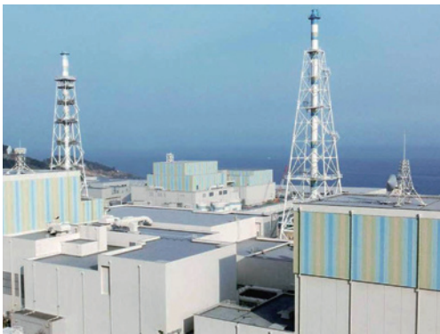
島根原子力発電所
