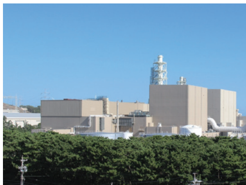
中部電力㈱浜岡原子力発電所
