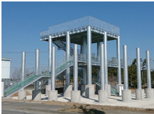
池新田地区津波避難タワー
