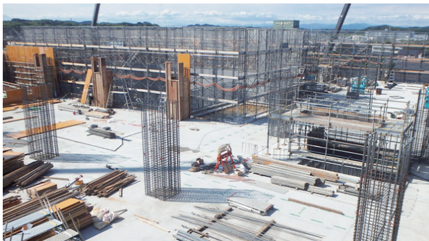
浜岡中学校校舎改築工事（8月31日現在） 4階東側床完了、柱配筋施工中【南から北を望む】
