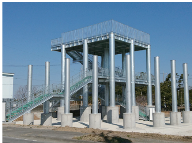
池新田地区津波避難タワー
