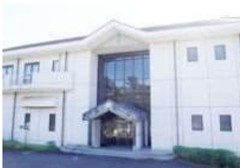
御前崎市池新田浄化センター
