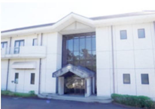
御前崎市池新田浄化センター
