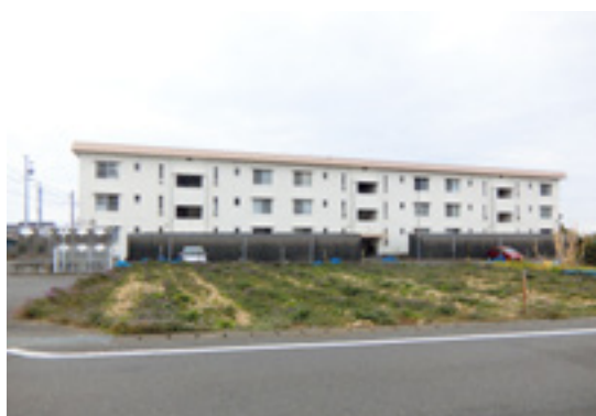
市営広沢住宅
