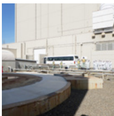
1、2号機共用排気筒解体跡地
