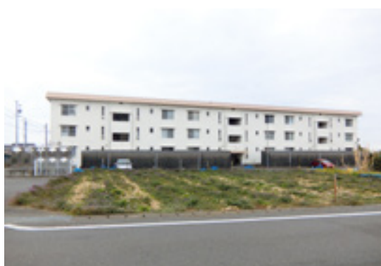
市営広沢住宅
