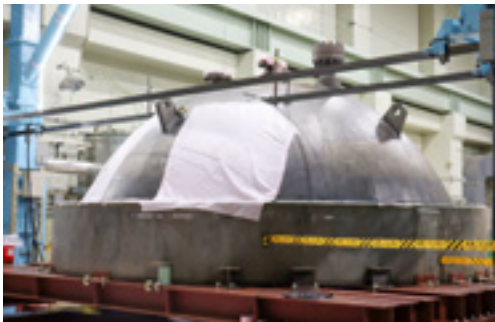
1号機原子炉圧力容器上蓋の解体の様子
