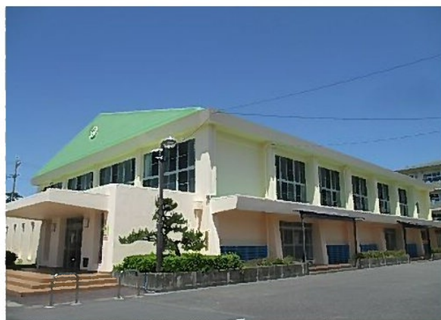
第一小学校体育館外壁塗装工事(H29)
