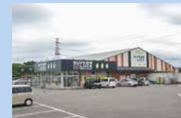
⑬国道150号ぞいのスーパー
