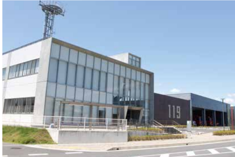
御前崎市消防本部・ 御前崎市消防署
