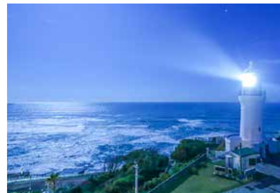
夜の海を照らす御前埼灯台
