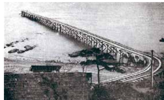
1948(昭和23)年、建設がはじまった東防波堤
