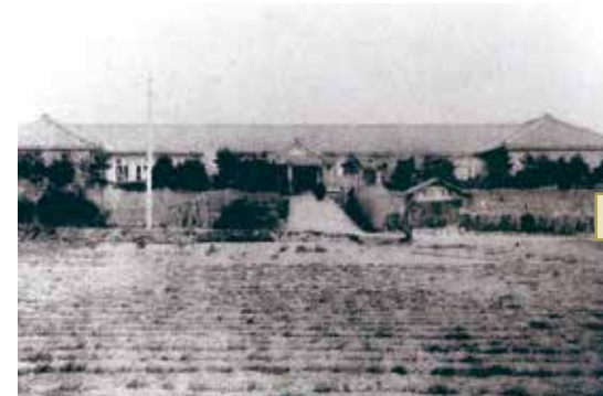
1909(明治42)年 御前崎尋常高等小学校
