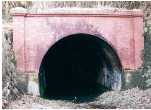
オットのトンネル跡 (新野)
