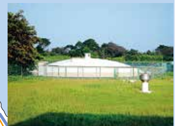
御前崎配水池
