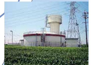
朝比奈配水池
