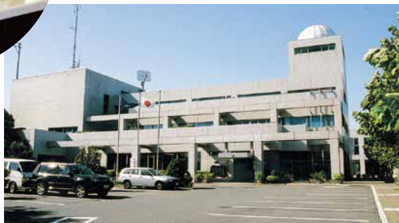
御前崎支所・消防署白羽出張所
