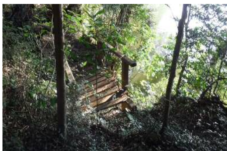
5 橋梁部②崩落箇所復旧工事着手前
