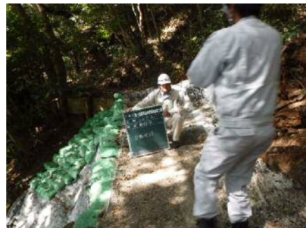
4 遊歩道崩落箇所復旧工事土嚢設置目視確認
