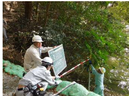
2 遊歩道崩落箇所復旧工事土嚢設置出来形検測
