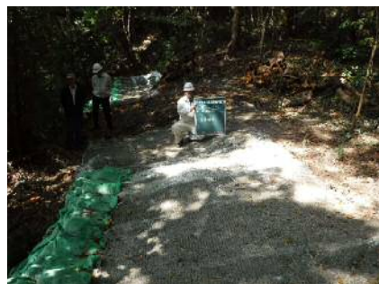
6 橋梁部復旧工事土嚢設置目視確認検査
