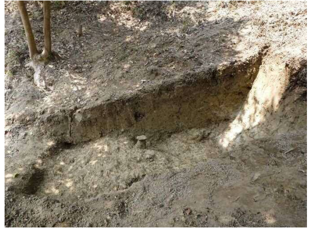
2 トレンチ 2 完掘状況
