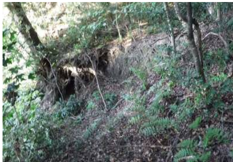
1 遊歩道崩落箇所復旧工事着手前
