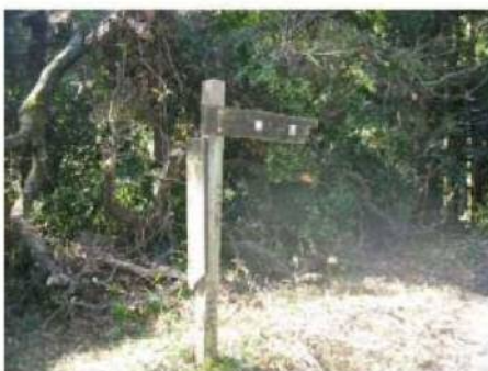
写真 25 遊歩道順路看板の状況
