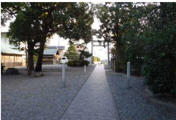
1 祭事用提灯やかた取付台設置着手前
