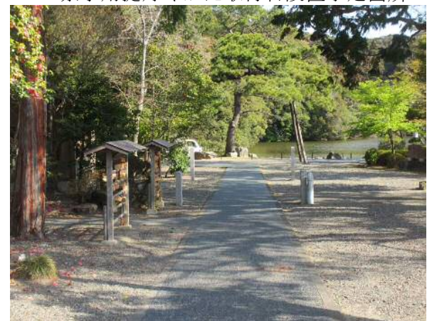
4 祭事用提灯やかた取付台設置完了(南側から)
