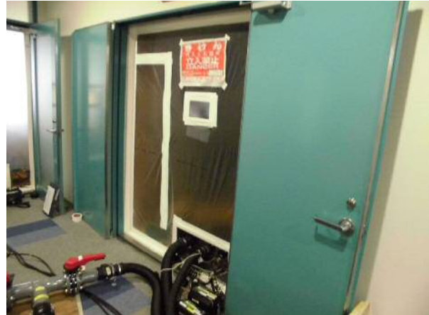
4 扉口密閉(収蔵庫)
