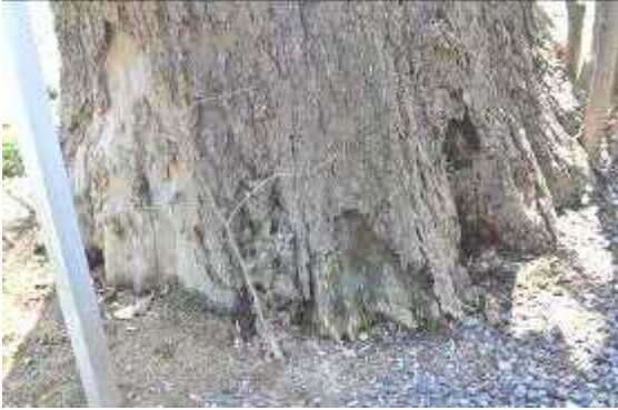
東側：組織は腐朽し樹皮が剥離し始めている。木質部にも支持力はない。
