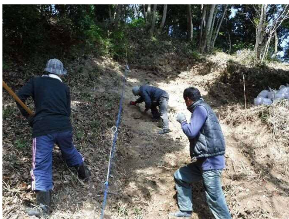
1 トレンチ1確認調査風景
