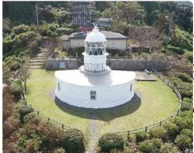
へさき 部埼灯台 (福岡県北九州市)
