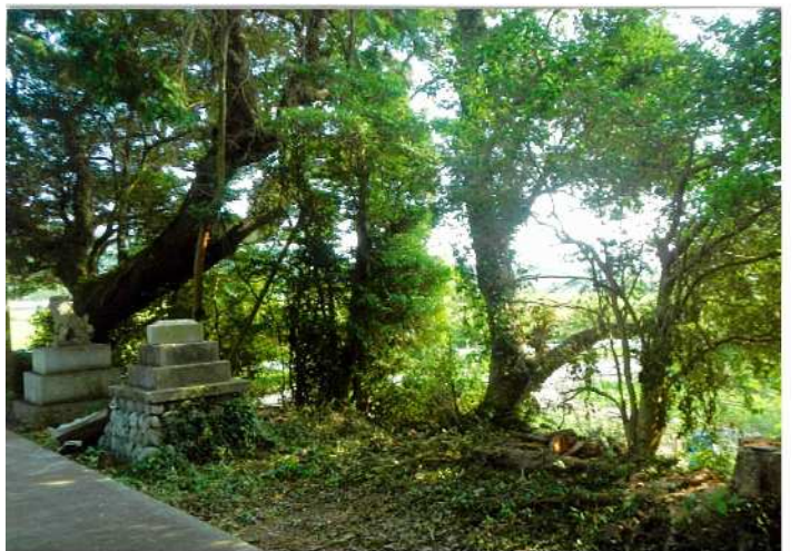
4 大径木 No.8 ホルトノキの倒木除去完了後の様子
