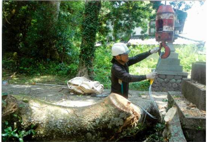
2 大径木 No.8 ホルトノキの玉掛け作業
