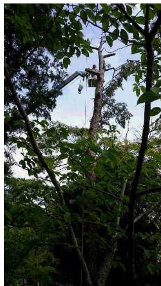
3 枯れた松の伐採風景
