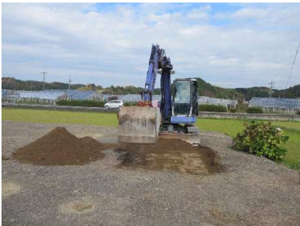
1 表土掘削作業
