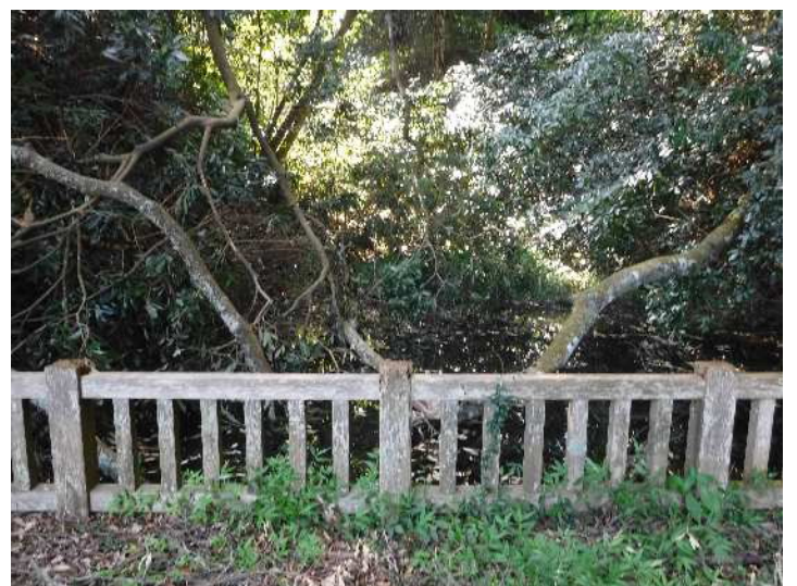
6 駐車場北側の調整池の木の枝の倒木状況
