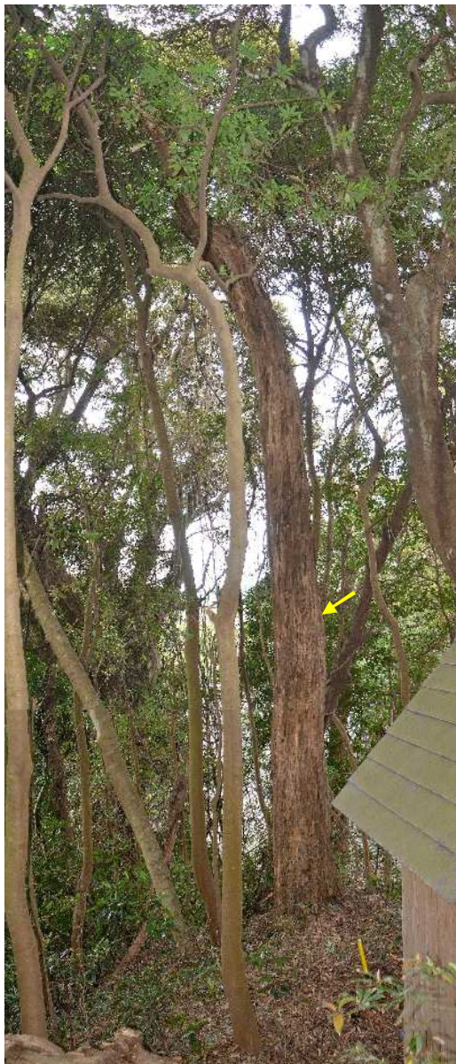
神社東側 3.6mの位置に樹種不明の枯死樹があり、切除する。
