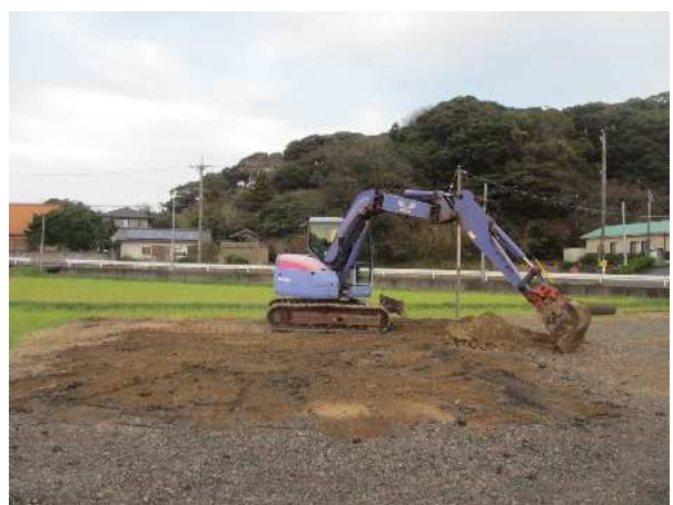
6 試掘坑の埋め戻し風景
