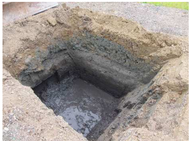
2 試掘坑1発掘状況
