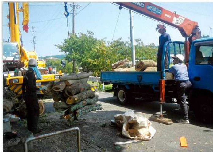
3 大径木 No.8 ホルトノキの積込撤去作業
