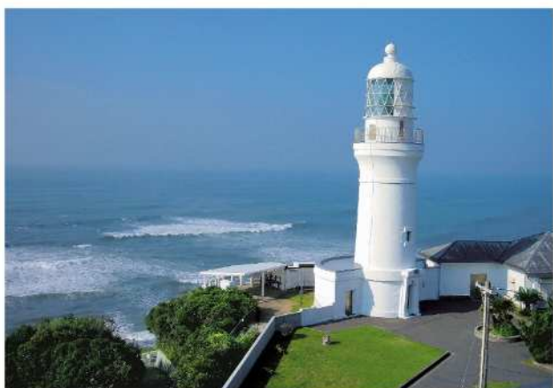
3 御前埼灯台全景
