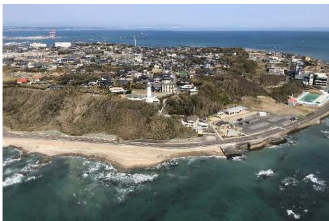
1 御前埼灯台敷地全景(海側上空から撮影)
