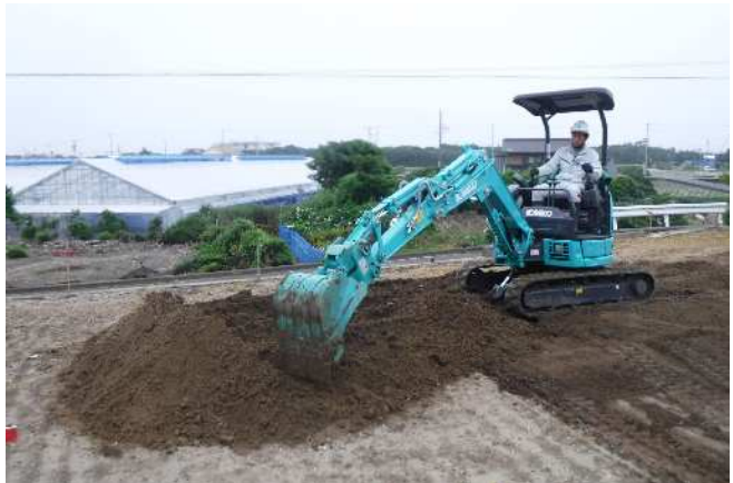
6 試掘坑1の埋め戻し風景
