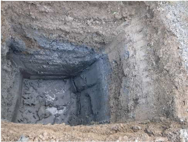
3 試掘坑1完掘状況
