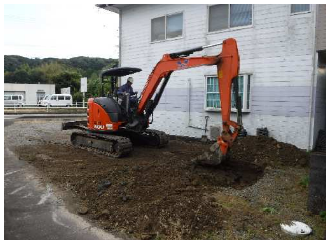
6 試掘坑1の埋め戻し風景
