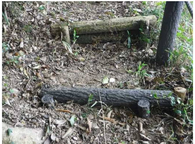
写真 13 遊歩道階段丸太プラ擬木製横木設置後 2
