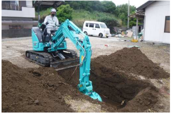
2 重機による試掘坑1の掘削風景
