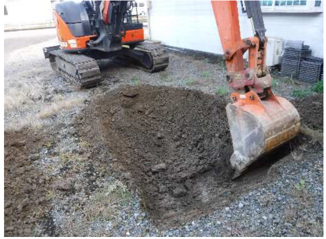
2 重機による試掘坑1の掘削風景
