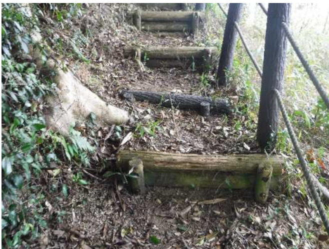
写真 12 遊歩道階段丸太プラ擬木製横木設置後 1
