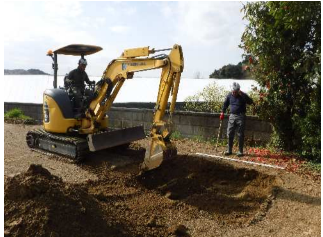
2 重機による試掘坑1の掘削風景
