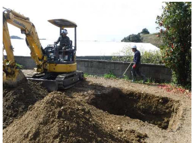
6 試掘坑1の埋め戻し風景
