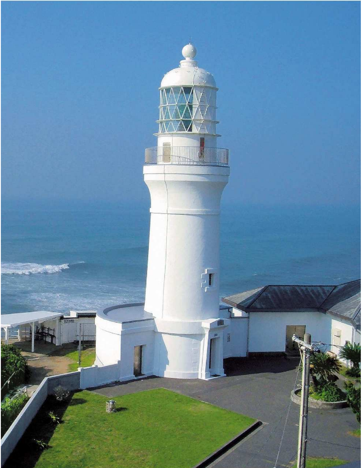
写真 1 国指定重要文化財「御前埼灯台」
