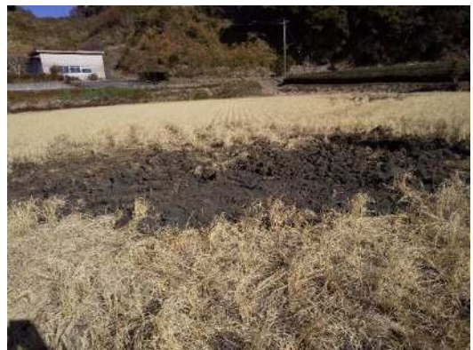
試掘坑 2 埋め戻し完了
