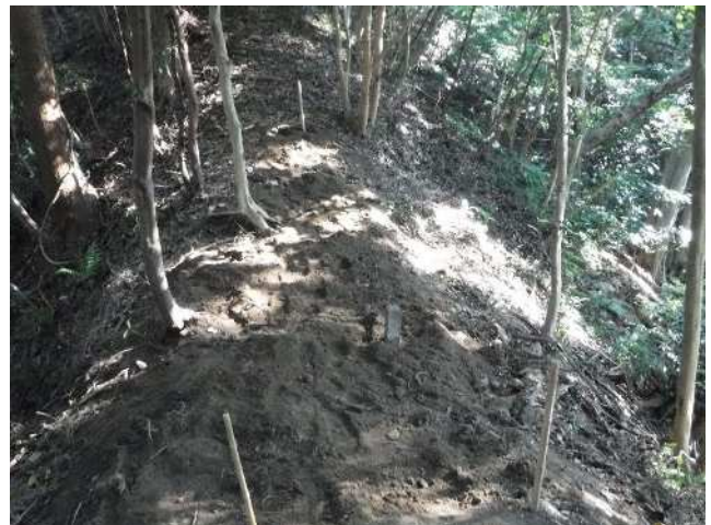
6 試掘坑 1 埋戻完了(北側から)
