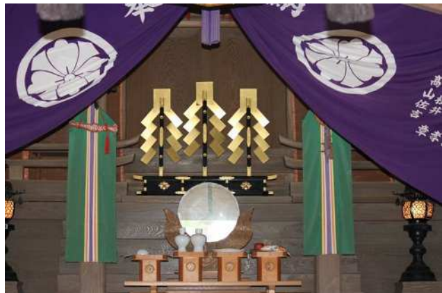
写真25 本殿階段及び框の損傷状況
