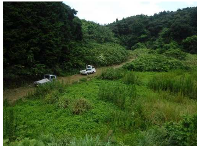
6 調査地点への進入路(農道)の草刈作業完了後
