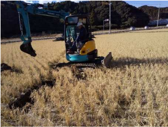
試掘坑 2 試掘調査掘削作業風景
