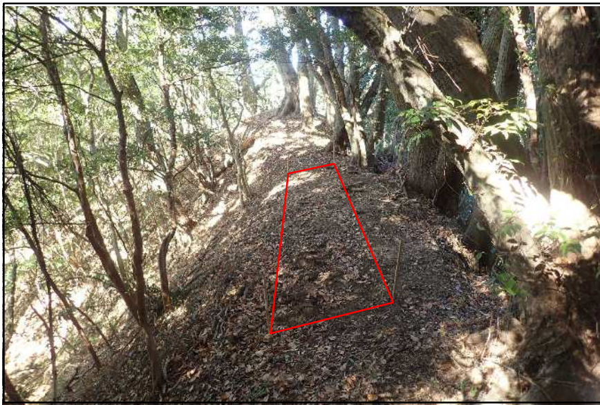
2 試掘坑2埋戻状況
