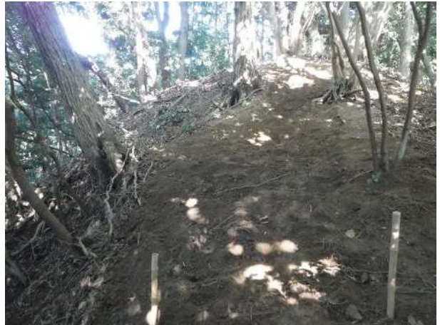
6 試掘坑3埋戻完了(北側から)
