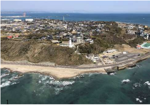
1 御前埼灯台敷地全景(海側上空から撮影)
