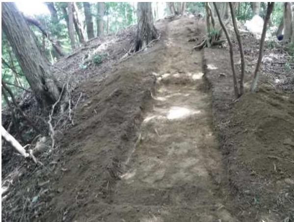
3 試掘坑3完掘(北側から)
