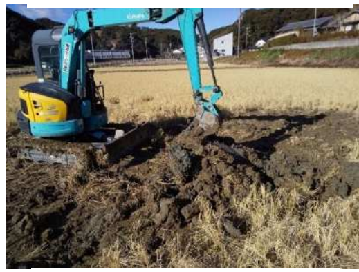
試掘坑 1 埋め戻し風景(近景)
