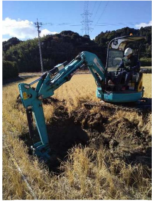
試掘坑 1 試掘調査掘削作業風景
