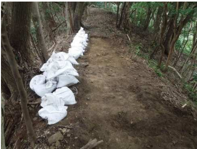
5 試掘坑 2 完掘(北側から)
