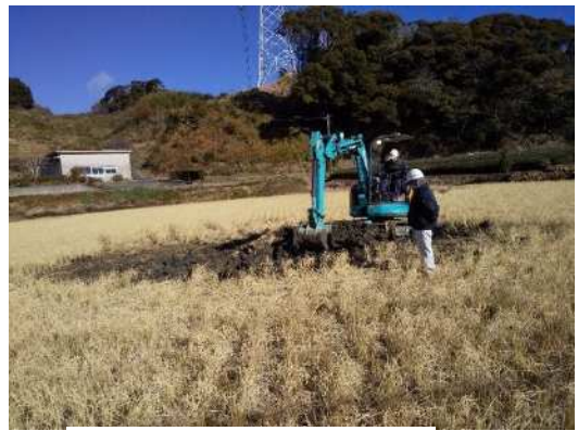
試掘坑 2 埋め戻し風景
