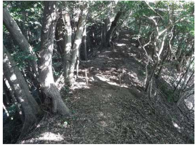
4 試掘坑 2 埋戻完了(北側から)
