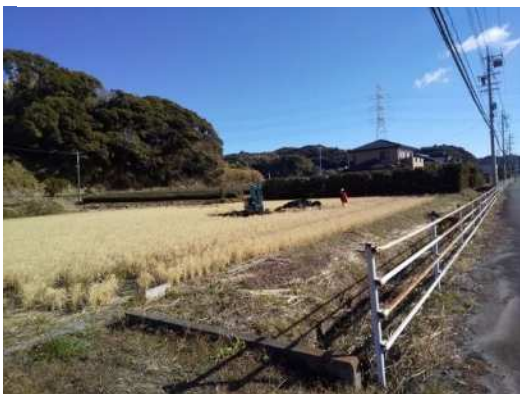
試掘坑 1 埋め戻し風景(遠景)
