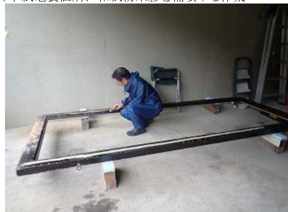
額の旧塗装面の除去作業
