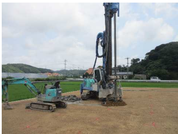
写真1 南谷遺跡工事立会
