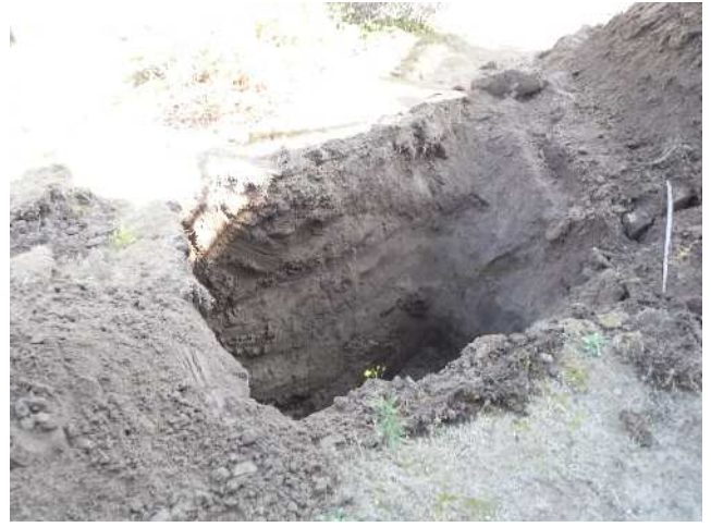
2 試掘坑 1 完掘状況
