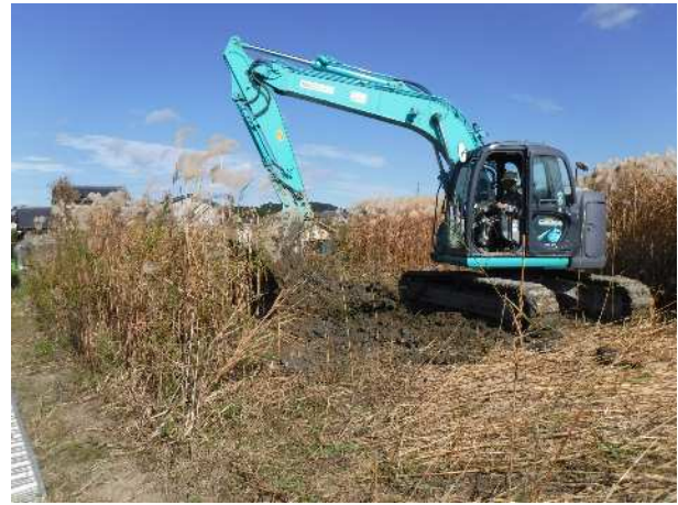
4 試掘坑 2 埋め戻し風景
