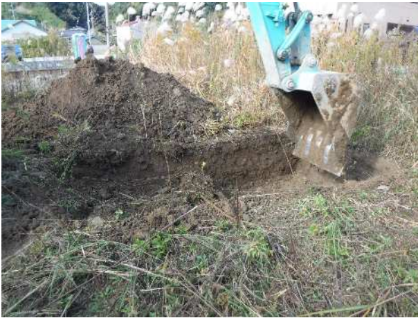
1 試掘坑 2 掘削風景
