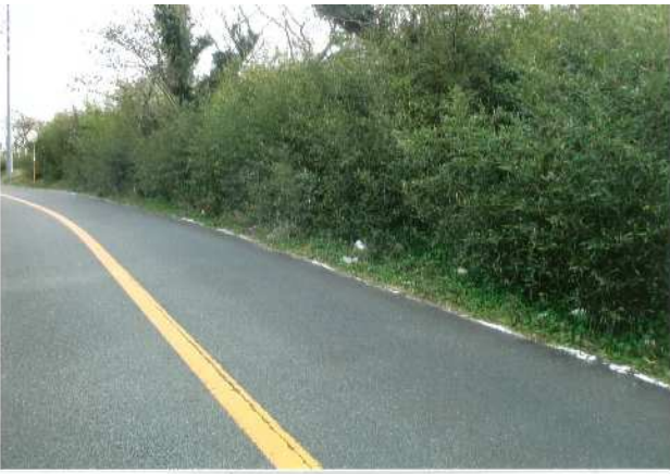
1 樹木剪定工事施工前
