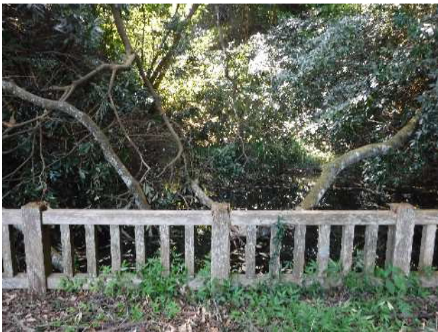
1 駐車場北側調整池の倒木被害状況
