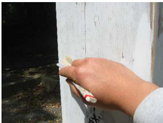
3 比木賀茂神社社叢標柱の修繕
