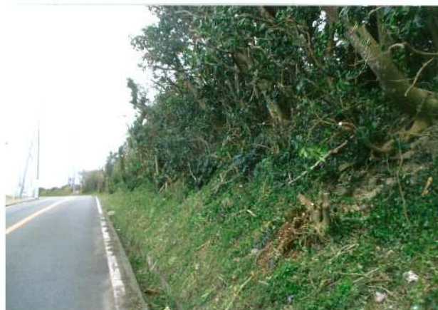
2 樹木剪定工事施工後
