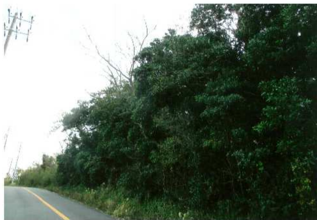
1 樹木剪定工事施工前
