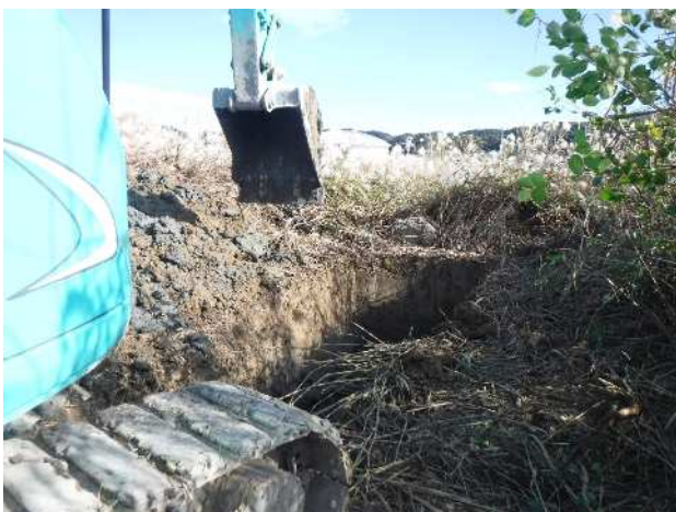
5 試掘坑 1 埋め戻し風景
