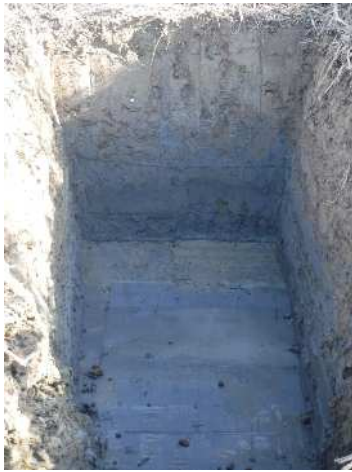
3 試掘坑 1 完掘状況
