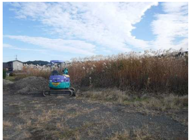
6 試掘坑 2 調査前全景
