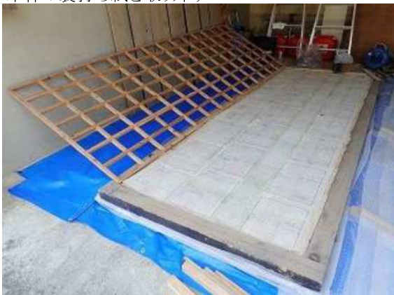
木枠を取り外した状況
