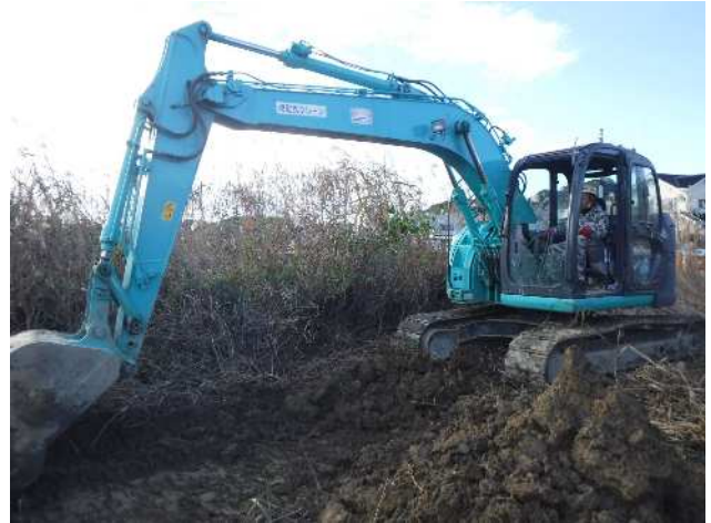
2 試掘坑 1 掘削風景
