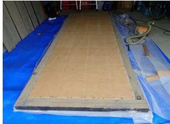
裏側の板を外した状況
