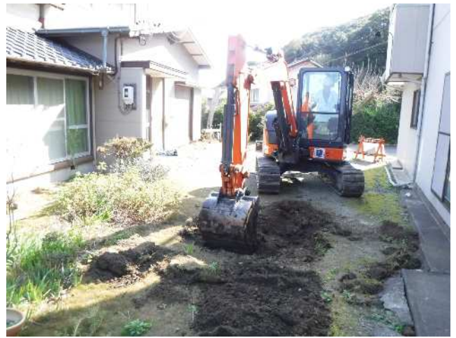
4 試掘坑 2 掘削着手風景
