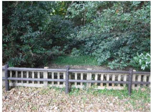
2 倒木撤去工事後の駐車場北側調整池
