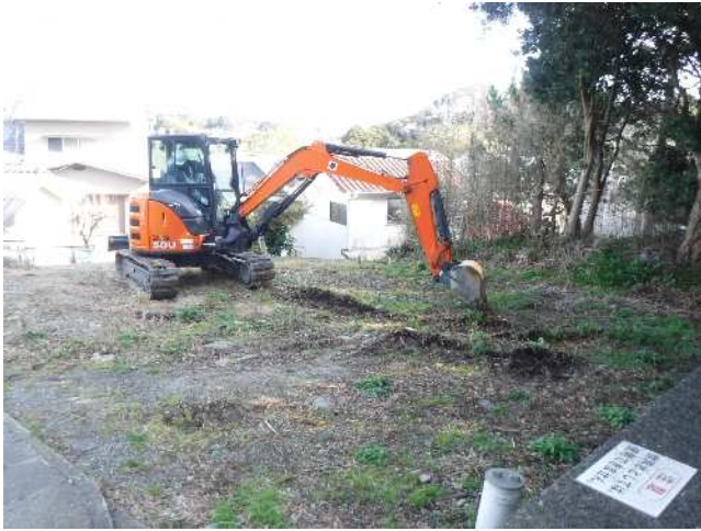
1 試掘坑 1 掘削着手風景
