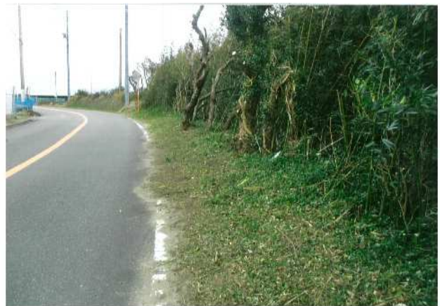
2 樹木剪定工事施工後
