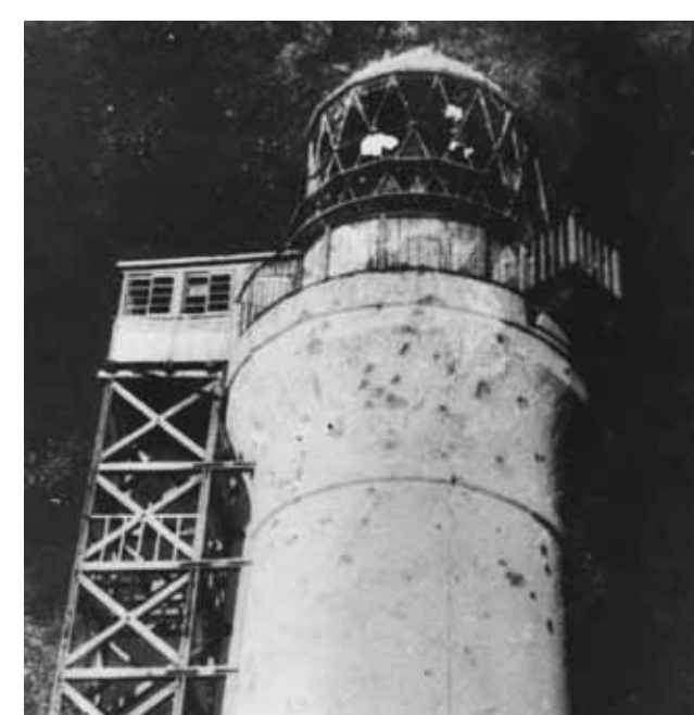
機銃掃射により、レンズや回転機械などが破損した御前埼灯台(昭和20年7月末頃に被弾)
