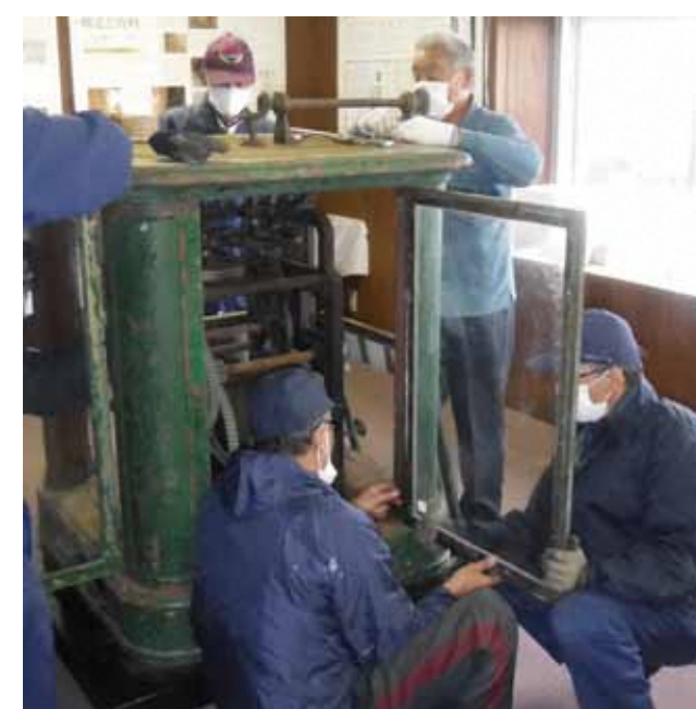
御前埼灯台資料館での「旧回転機械分銅自動巻揚装置」の組み立て及び設置作業
