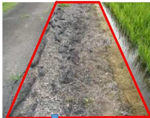
除草剤を使用している路肩
