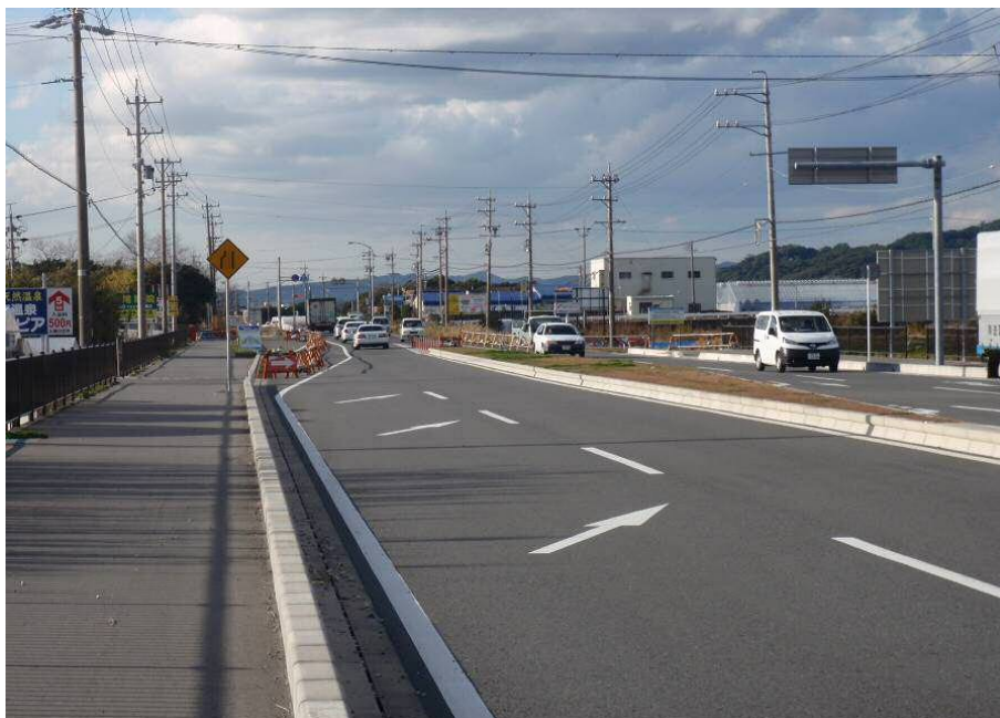
4車線化が待たれる国道150号
