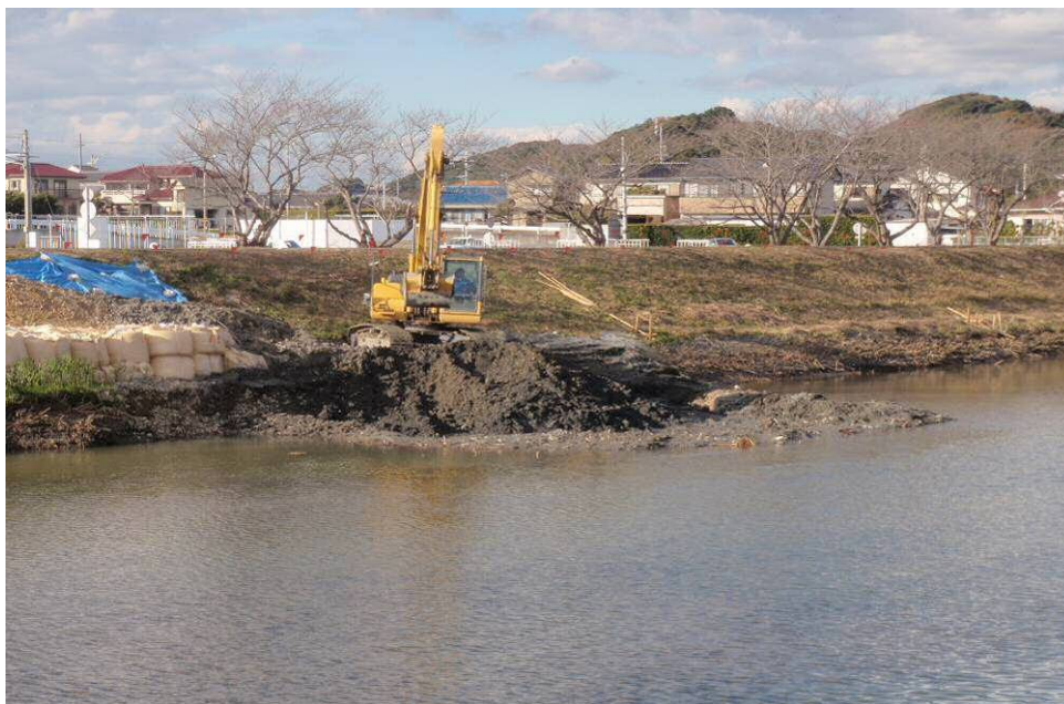
河川維持のため、河川床の掘削をする新野川
