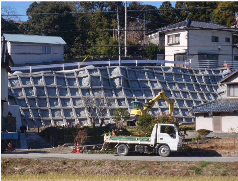
上比木地区の急傾斜地崩壊対策工事
