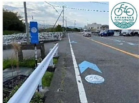
太平洋岸自転車道の統一ロゴと太平洋岸自転車道の走行空間整備 市内ルートへの誘導(矢羽根、案内サイン)
