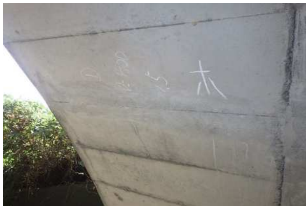
(1) アーチ部分の損傷：ひびわれ
