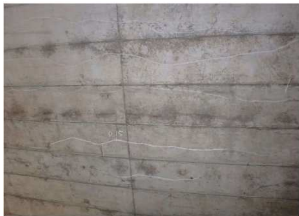
(1) 頂版コンクリートの損傷：ひびわれ
