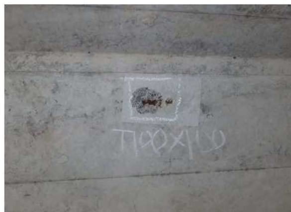
(2) 側壁コンクリートの損傷：剥離、鉄筋露出
