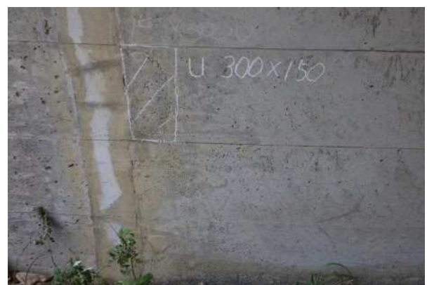
(2) 側壁の損傷：うき、剥離
