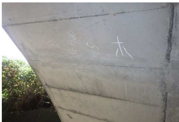
(1) アーチ部分の損傷：ひびわれ
