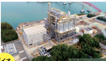
四日市バイオマス発電所 (※1)
