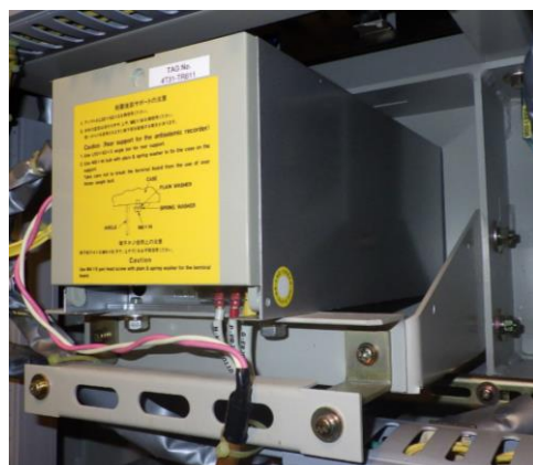
記録計を固定する耐震サポートへの取り付け
