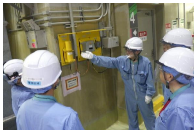
燃料プール付近に設置した 放射線モニタを確認している様子
