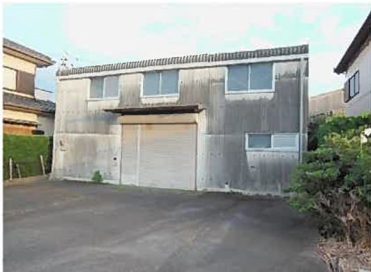
朝比奈原防災倉庫
