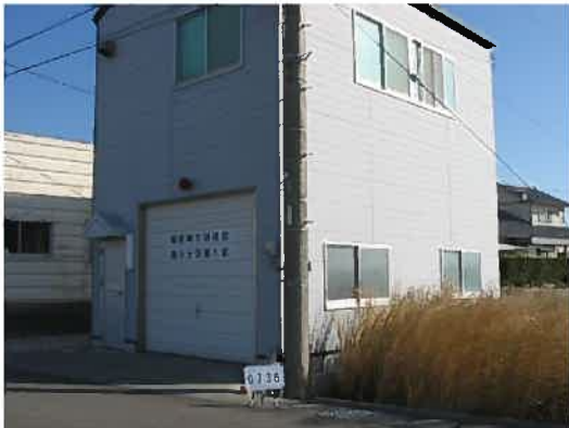
中原区防災倉庫
