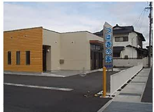
御前崎つばき作業場
