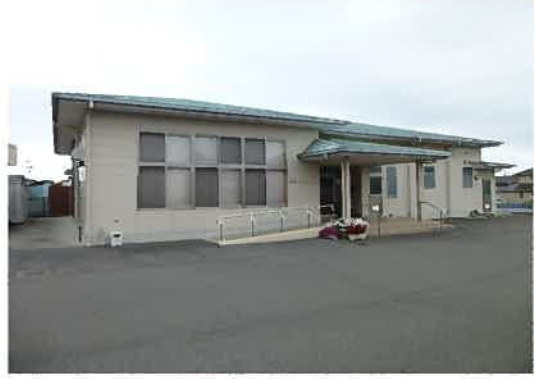
女岩区コミュニティ防災センター
